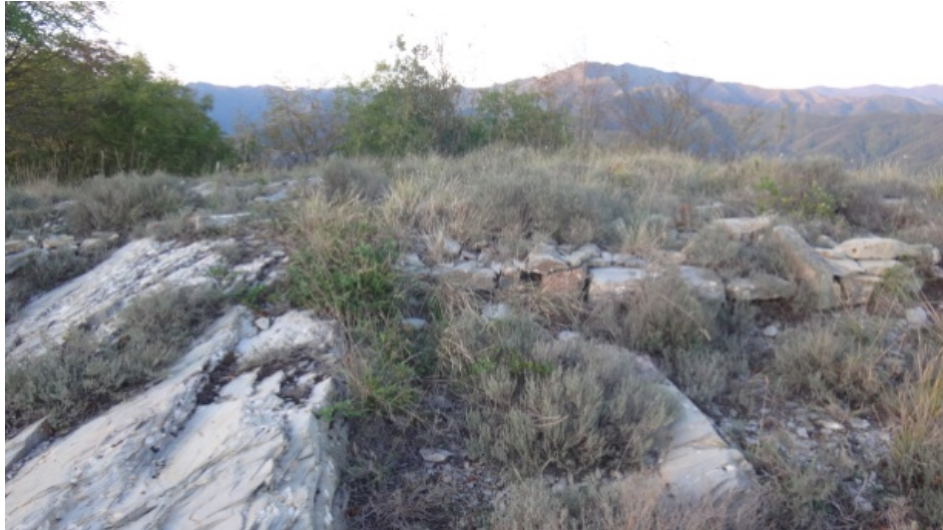
Figura 37. Resti del torrione N.
