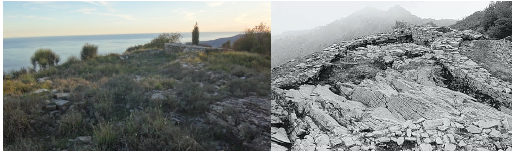
Figura 35. (SX) Stato attuale del torrione Sud (DX) area di scavo al termine dei lavori nel 1997
