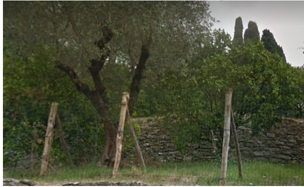
Figura 55. Muri di contenimento della proprietà in via Privata Sage.
