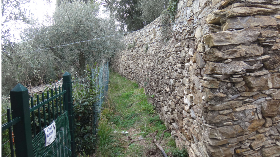
Figura 44. Murature a secco ristrutturare.
